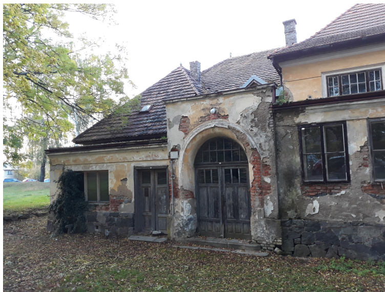
Obrázek 1: Současný pohled na vchod Sokolovny (foto autor)
